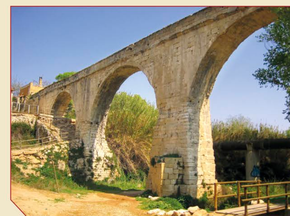
// Acueducto Los Arcos en la senda fluvial del río Guadalupe.
